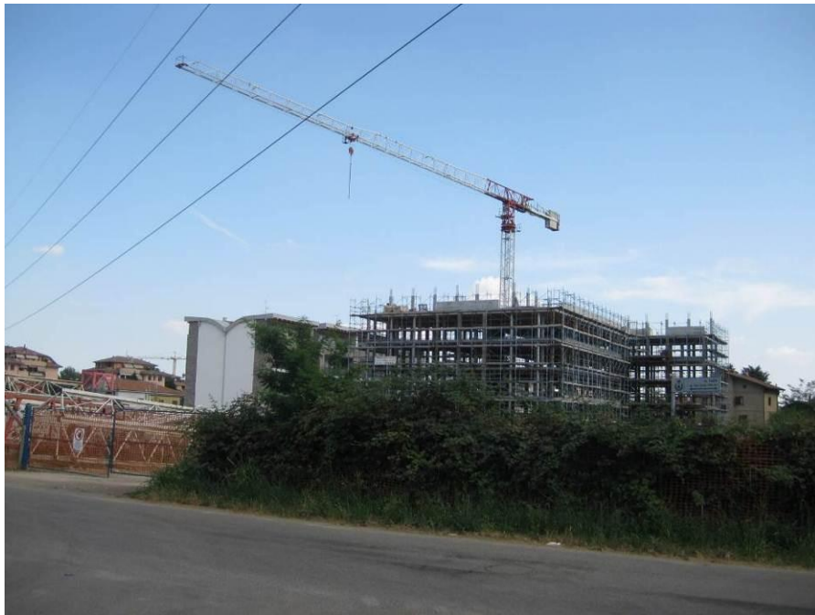
Il cantiere di via Lazio - luglio 2012
